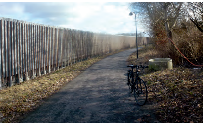
Eksempel på støjskærm ved motorvej.
